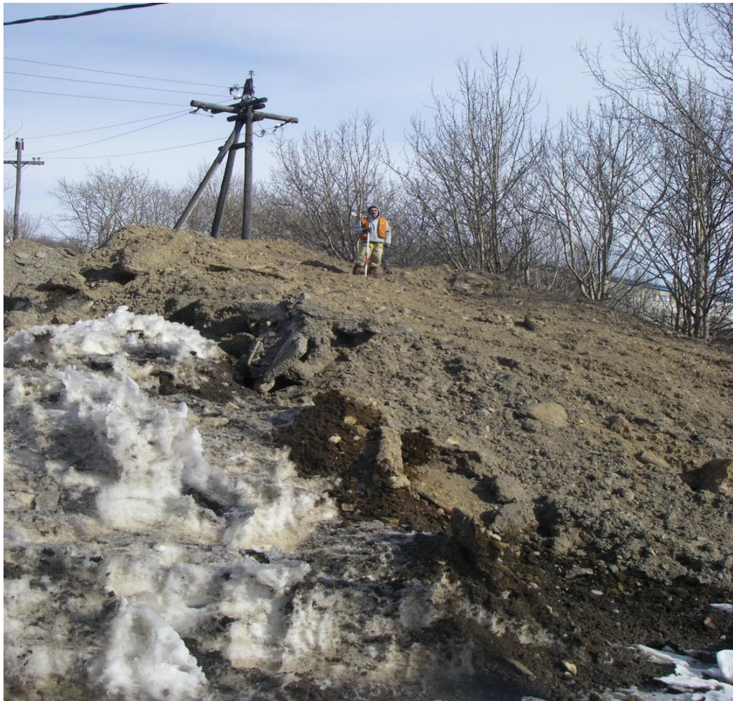
Рис. 9. Место нахождения засыпанного канализационного колодца
