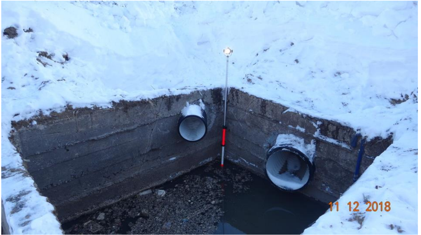
Рис. 3. Съемка канализационного коллектора
