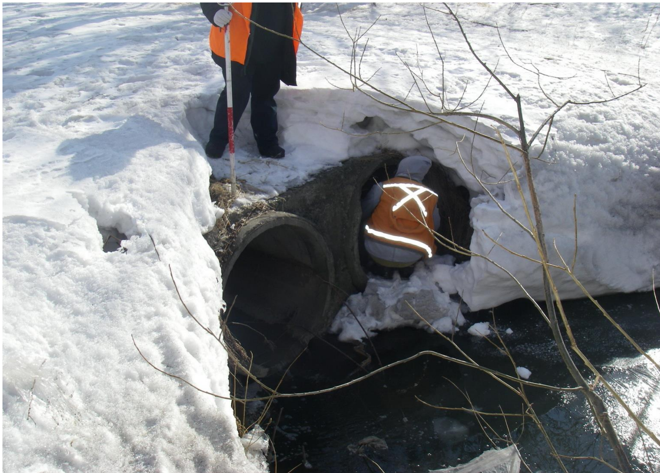
Рис. 7. Обследования труб на выходе канализации в оз. Култучное
