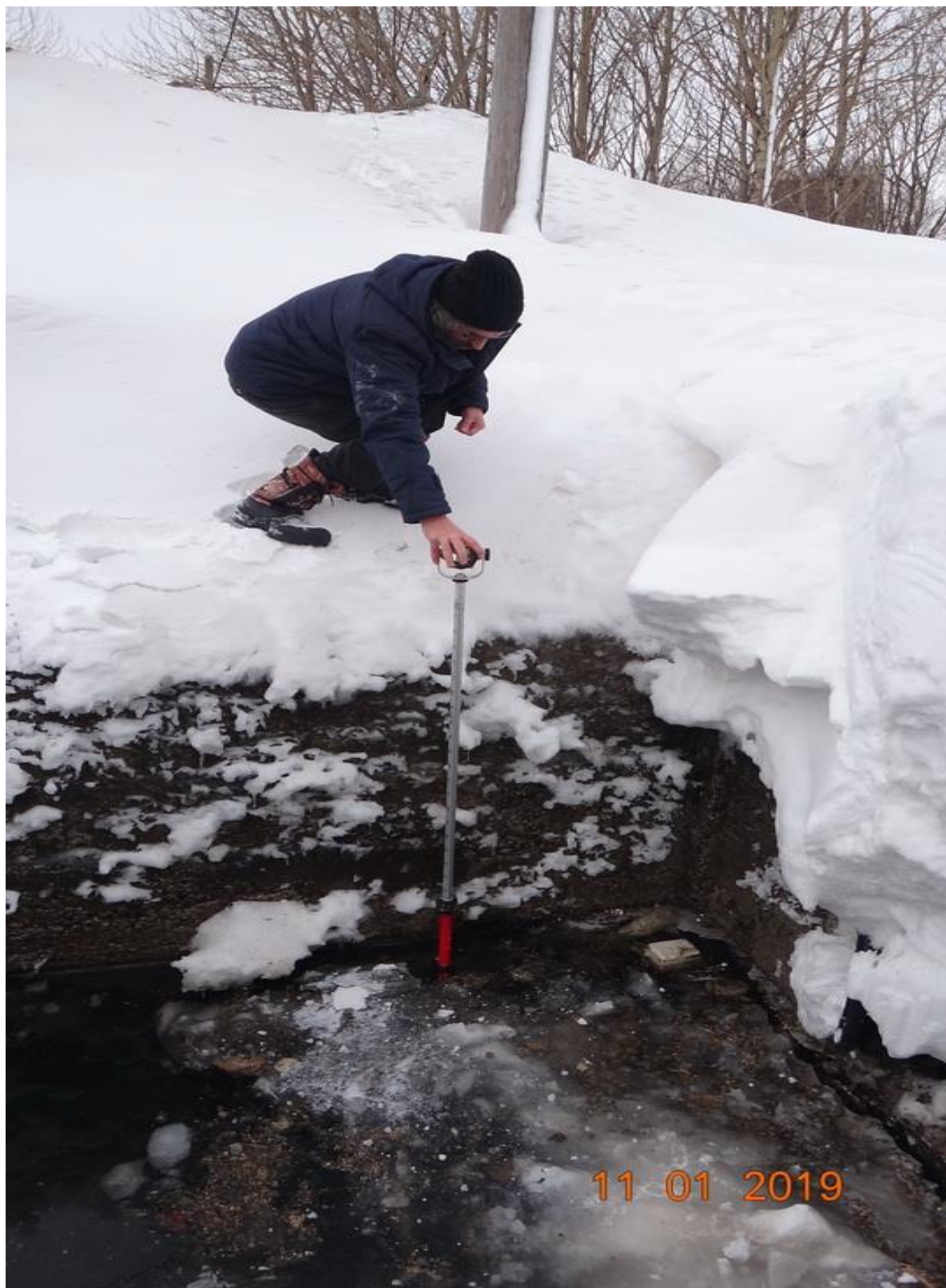
Рис. 5. Измерения глубины канализационного коллектора
